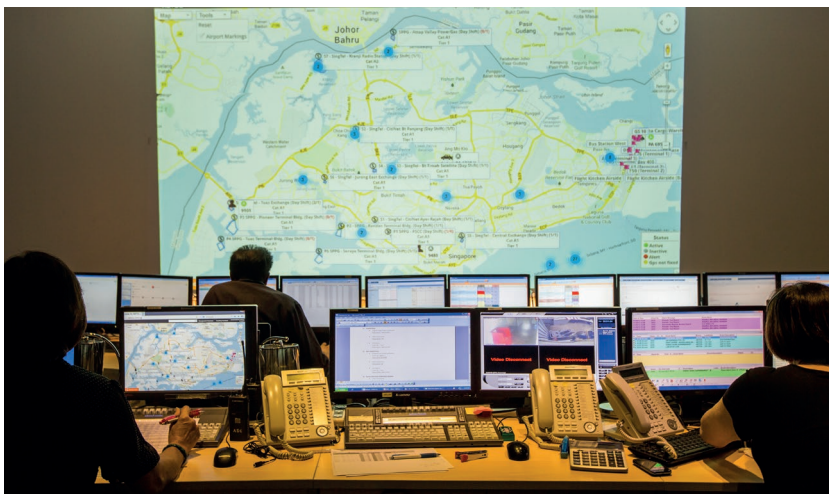
Das AETOS Kontrollzentrum
